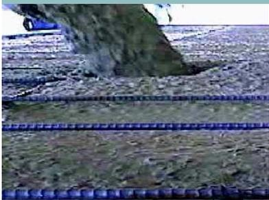
capaz de fluir en el interior del encofrado, rellenando de forma natural el volumen del mismo, pasando entre las barras de armadura y consolidándose únicamente bajo la acción de su propio peso pero sin compactación interna o externa.
